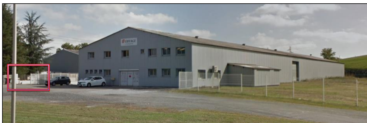
Portail – Entrée du site
